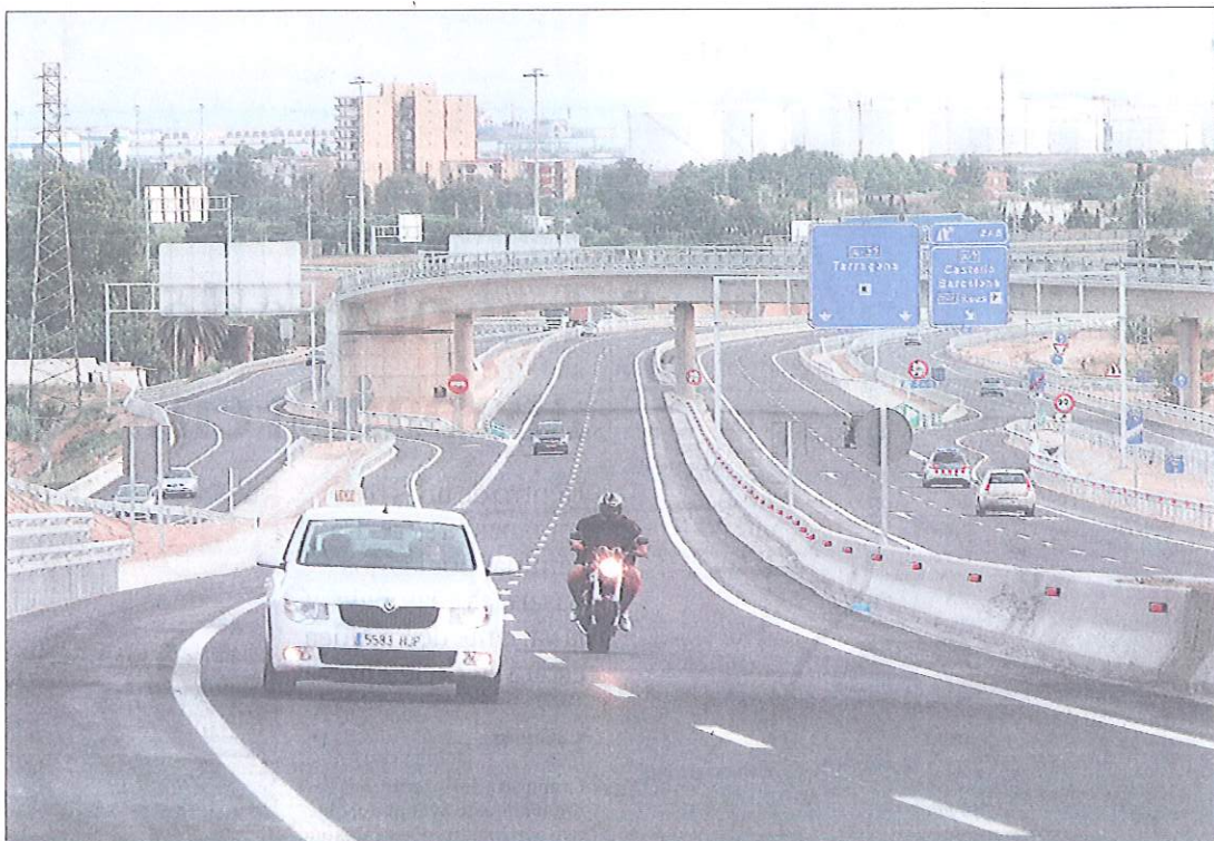
Los vehículos empezaron a circular ayer por la tarde por la nueva autovía, que une la ciudad de Tarragona con la localidad de El Morell. FOTO: PERE FERRÉ
